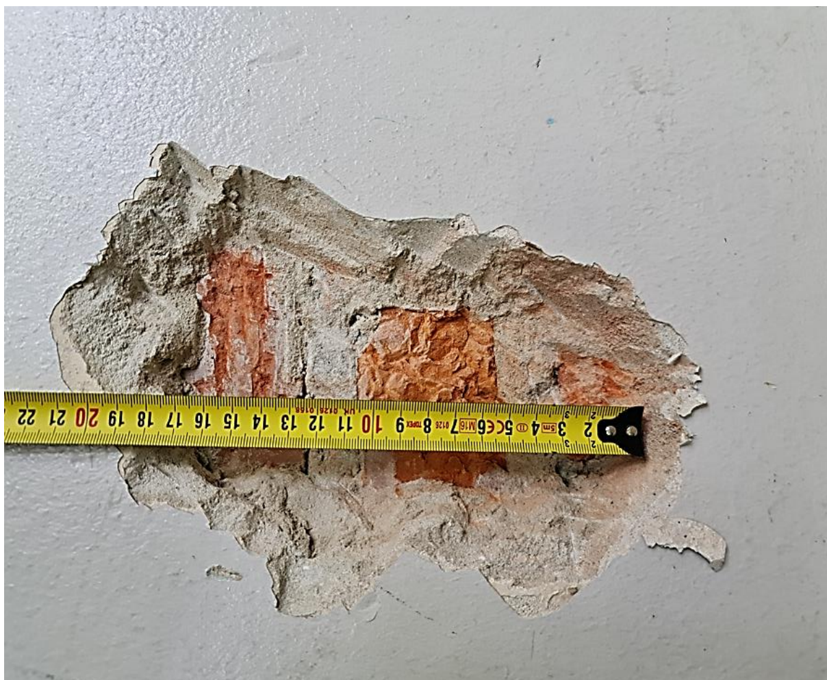
FOT. 6. Odkrywka muru ściany nośnej piwnicy
